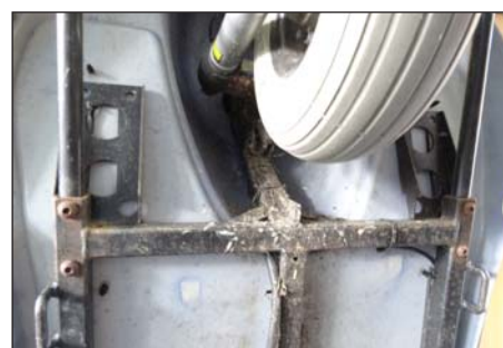
Nahoře vidíte, že správný postup repasování musí jít až do detailu. Dolní špatně repasovaný vozík vykazuje známky opotřebení.
